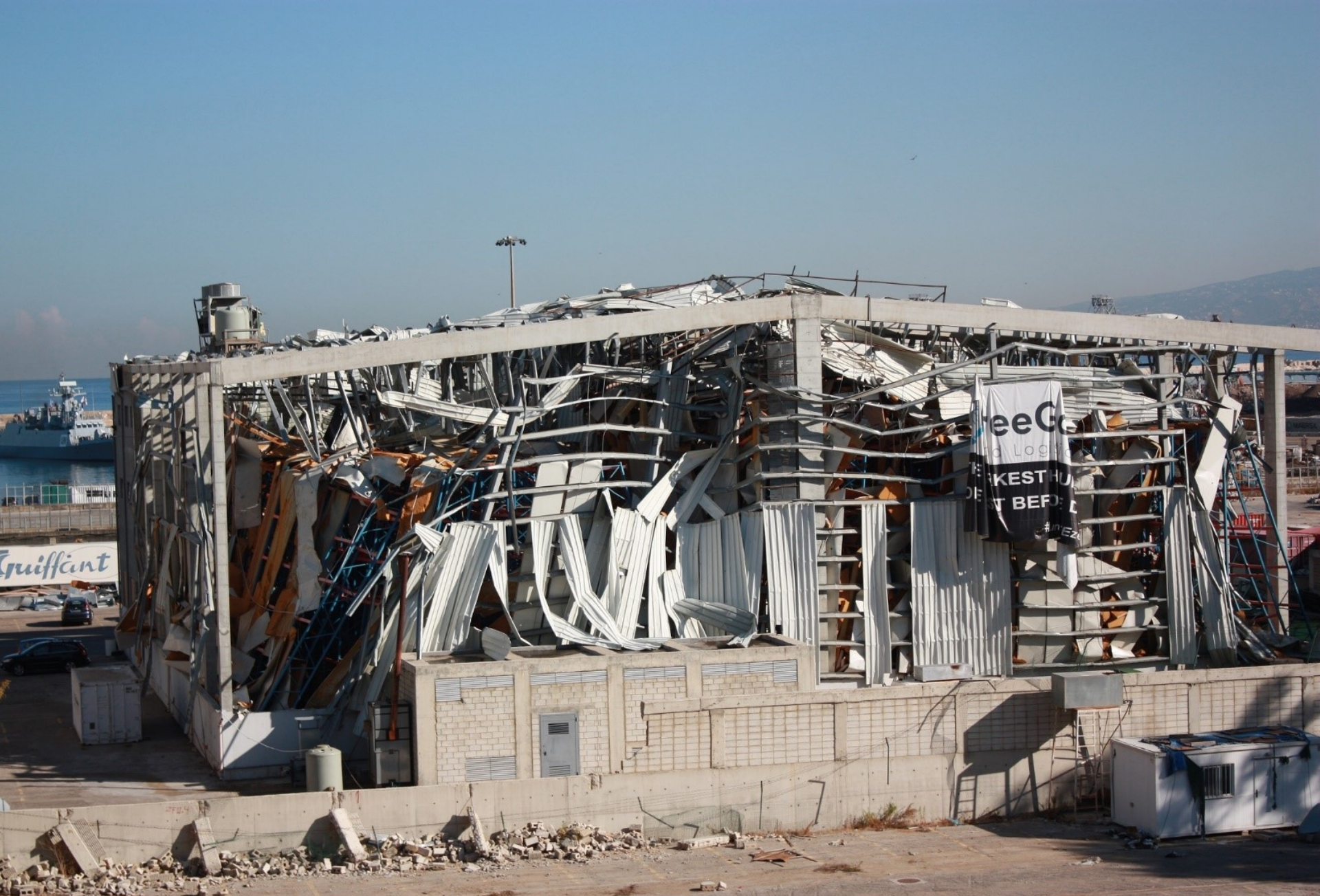
Eine zerstörte Lagerhalle im Hafengelände zeigt die Wucht der Explosion vom 4. August, die ca. 20 % der Stadtfläche von Beirut in wenigen Sekunden in eine Trümmerlandschaft verwandelte.
