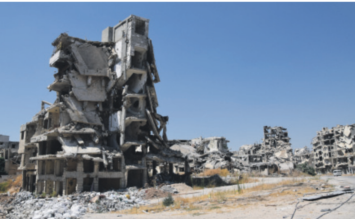
Zerstörtes Stadtviertel in Homs. KIZ/JW
